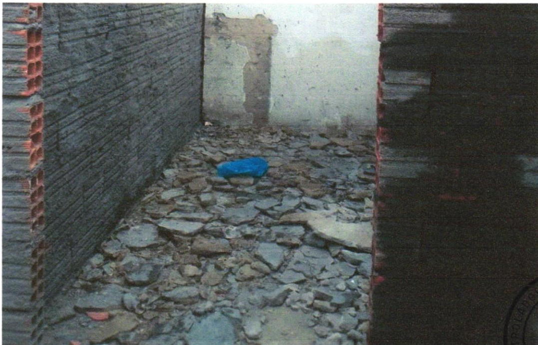
FOTO 04 - Demolição manual de piso cimentado sobre lastro de concreto - Rev 01
