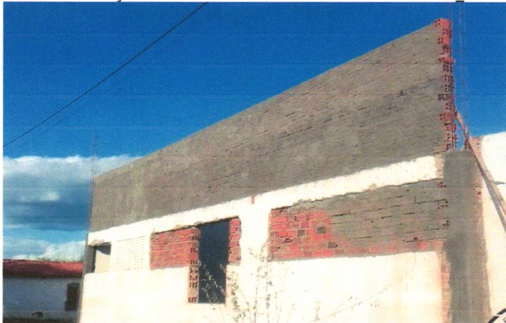
Foto 18 - CHAPISCO APLICADO EM ALVENARIA (COM PRESENÇA DE VÃOS) E ESTRUTURAS DE CONCRETO DE FACHADA, COM EQUIPAMENTO DE PROJEÇÃO. ARGAMASSA TRAÇO 1:3 COM PREPARO EM BETONEIRA 400 L. AF_06/2014
