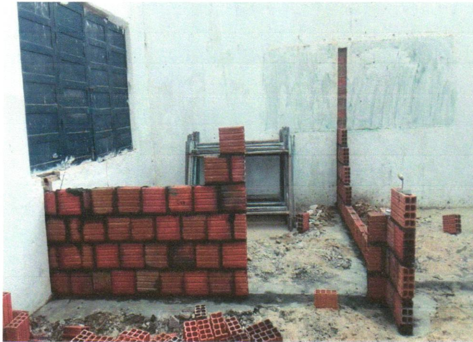
Foto 13 - ALVENARIA DE VEDAÇÃO DE BLOCOS CERÂMICOS FURADOS NA HORIZONTAL DE 9X19X29 CM (ESPESSURA 9 CM) E ARGAMASSA DE ASSENTAMENTO COM PREPARO EM BETONEIRA. AF_12/2021
