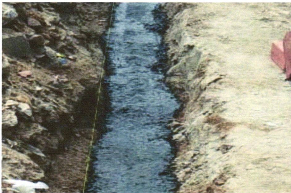
FOTO 11 - LASTRO DE CONCRETO MAGRO, APLICADO EM BLOCOS DE COROAMENTO OU SAPATAS, ESPESSURA DE 3 CM. AF_08/2017
