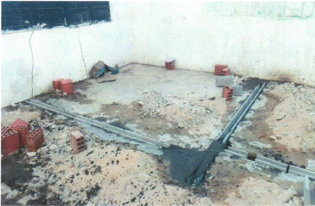
FOTO 09 - Bloco cerâmico tipo "u" (calha) 9x19x19cm
