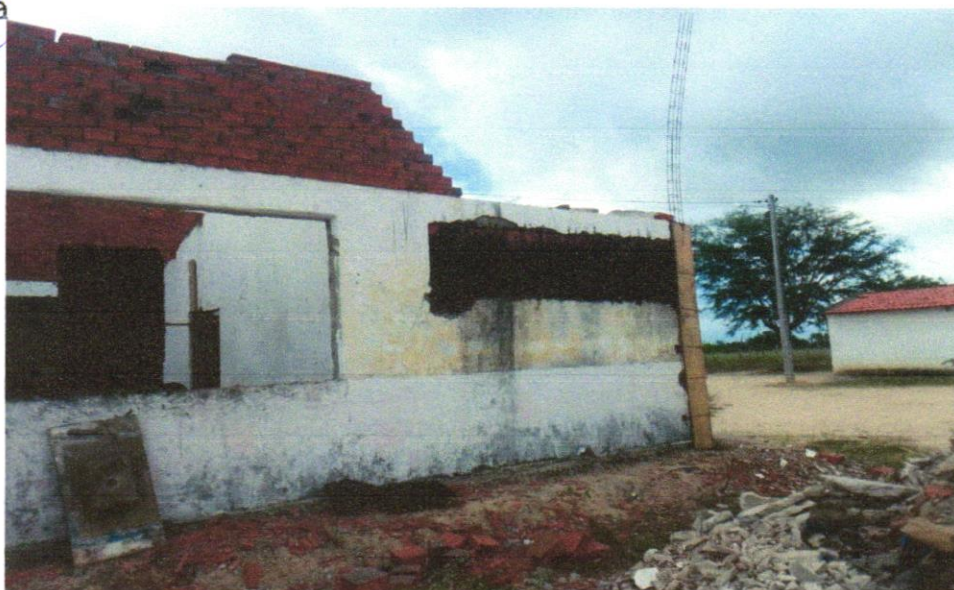
Foto 12 - ALVENARIA DE VEDAÇÃO DE BLOCOS CERÂMICOS FURADOS NA HORIZONTAL DE 9X19X29 CM (ESPESSURA 9 CM) E ARGAMASSA DE ASSENTAMENTO COM PREPARO EM BETONEIRA. AF_12/2021
