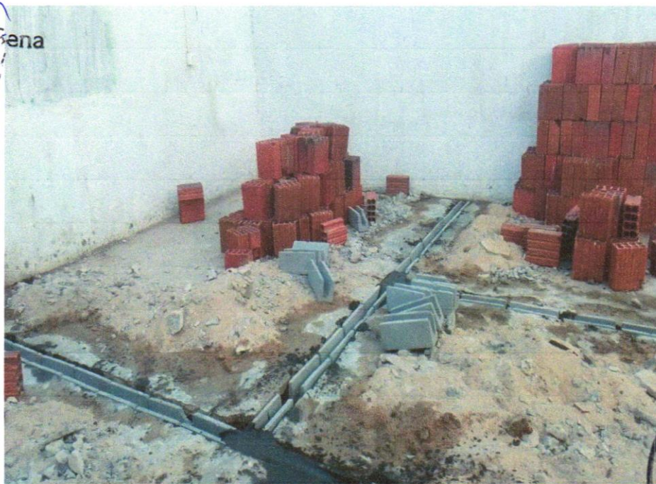
FOTO 08- Bloco cerâmico tipo "u" (calha) 9x19x19cm
