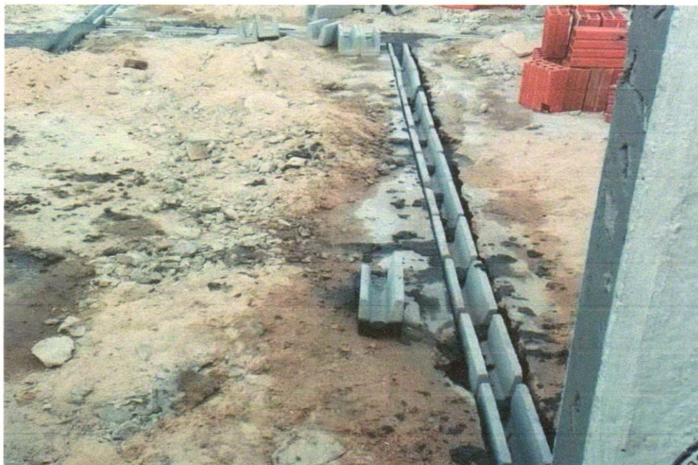
FOTO 10 - Bloco cerâmico tipo "u" (calha) 9x19x19cm
