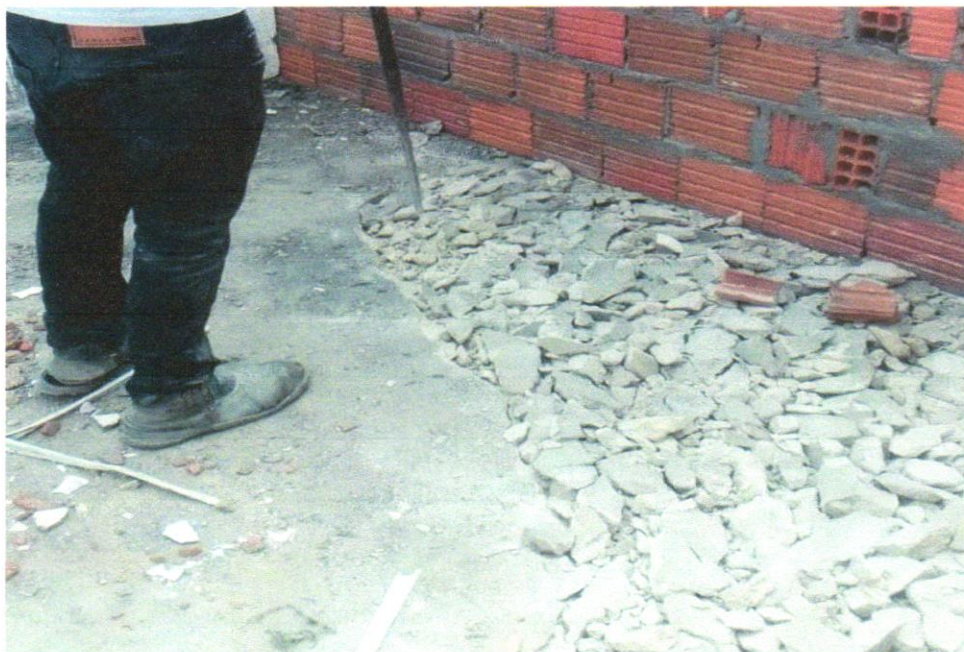
FOTO 05 - Demolição manual de piso cimentado sobre lastro de concreto - Rev 01
