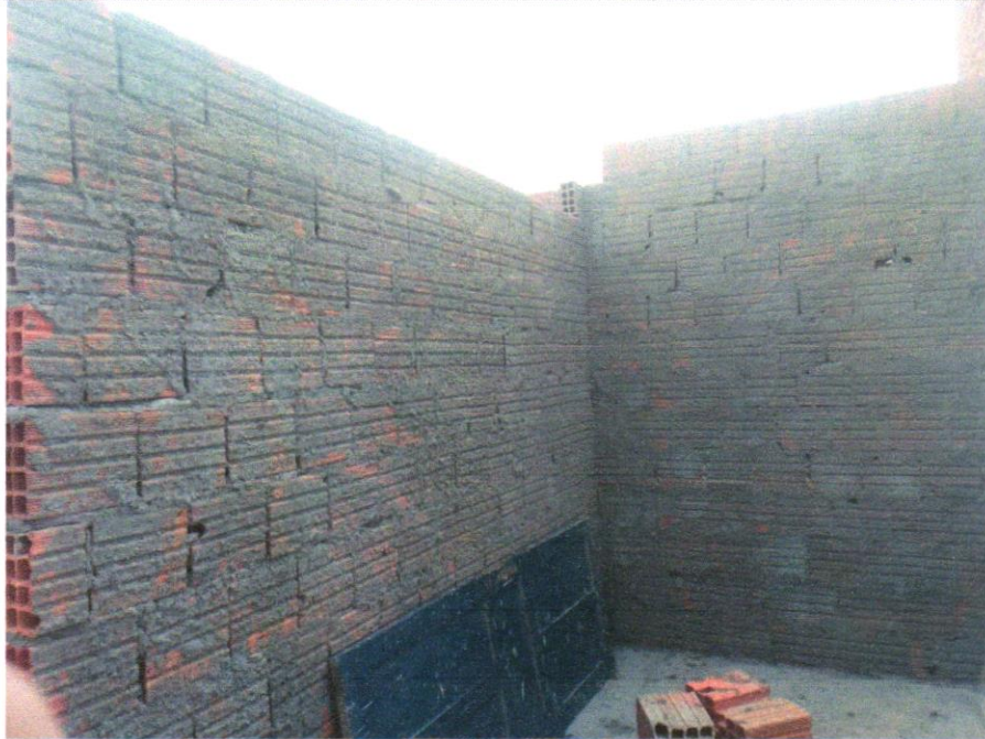
Foto 21 - CHAPISCO APLICADO EM ALVENARIA (COM PRESENÇA DE VÃOS) E ESTRUTURAS DE CONCRETO DE FACHADA, COM EQUIPAMENTO DE PROJEÇÃO. ARGAMASSA TRAÇO 1:3 COM PREPARO EM BETONEIRA 400 L. AF_06/2014
