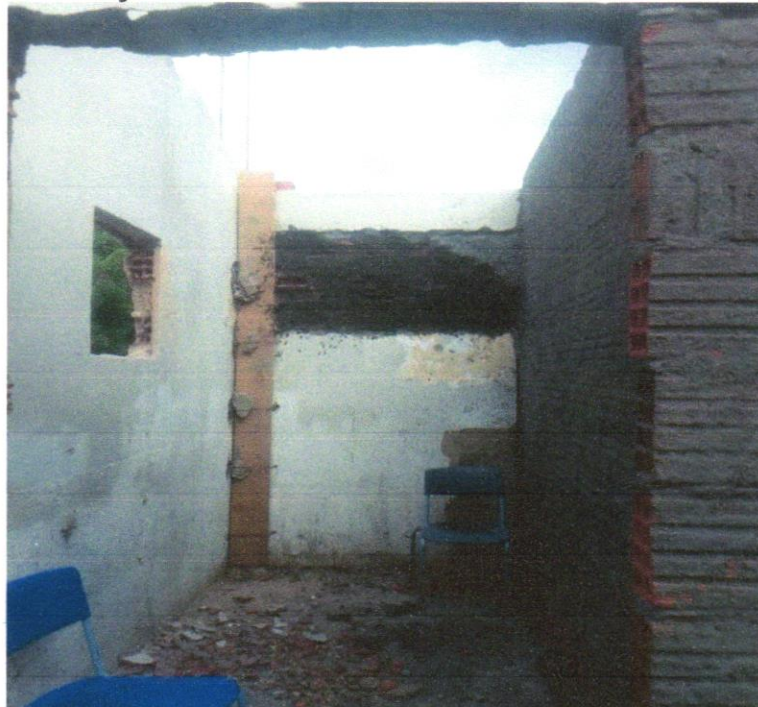
Foto 20 - CHAPISCO APLICADO EM ALVENARIA (COM PRESENÇA DE VÃOS) E ESTRUTURAS DE CONCRETO DE FACHADA, COM EQUIPAMENTO DE PROJEÇÃO. ARGAMASSA TRAÇO 1:3 COM PREPARO EM BETONEIRA 400 L. AF_06/2014
