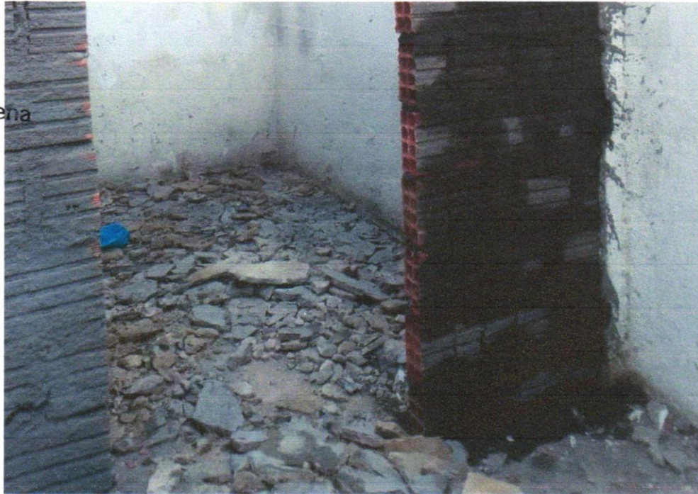
FOTO 03 - Demolição manual de piso cimentado sobre lastro de concreto - Rev 01
