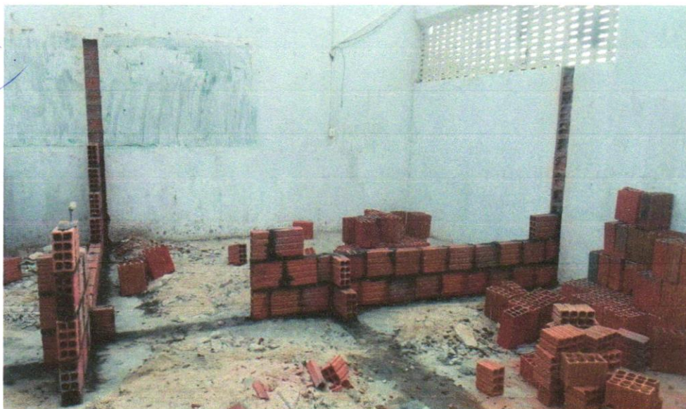
Foto 14 - ALVENARIA DE VEDAÇÃO DE BLOCOS CERÂMICOS FURADOS NA HORIZONTAL DE 9X19X29 CM (ESPESSURA 9 CM) E ARGAMASSA DE ASSENTAMENTO COM PREPARO EM BETONEIRA. AF_12/2021
