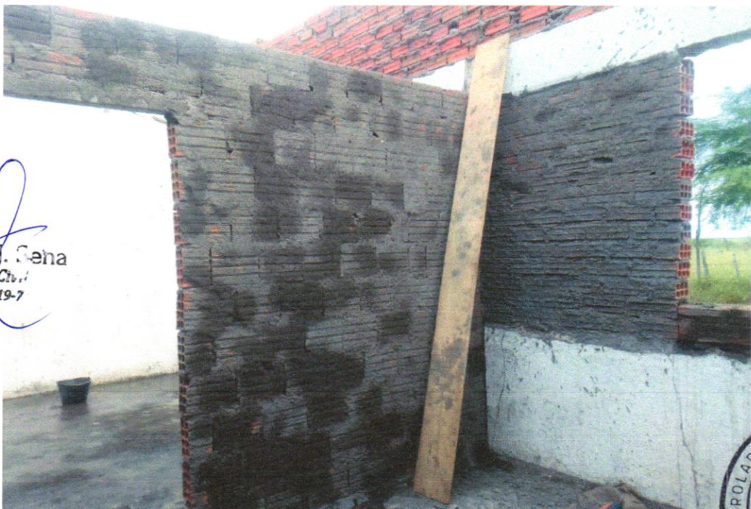
Foto 22 - CHAPISCO APLICADO EM ALVENARIA (COM PRESENÇA DE VÃOS) E ESTRUTURAS DE CONCRETO DE FACHADA, COM EQUIPAMENTO DE PROJEÇÃO. ARGAMASSA TRAÇO 1:3 COM PREPARO EM BETONEIRA 400 L. AF_06/2014
