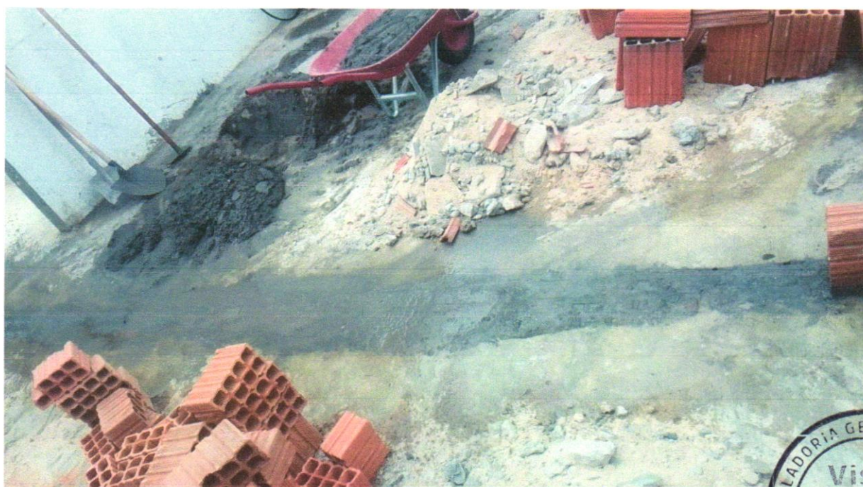
Foto 16 - CONCRETO FCK = 20MPA, TRAÇO 1:2,7:3 (EM MASSA SECA DE CIMENTO/ AREIA MÉDIA/ BRITA 1) - PREPARO MECÂNICO COM BETONEIRA 400 L. AF_05/2021
