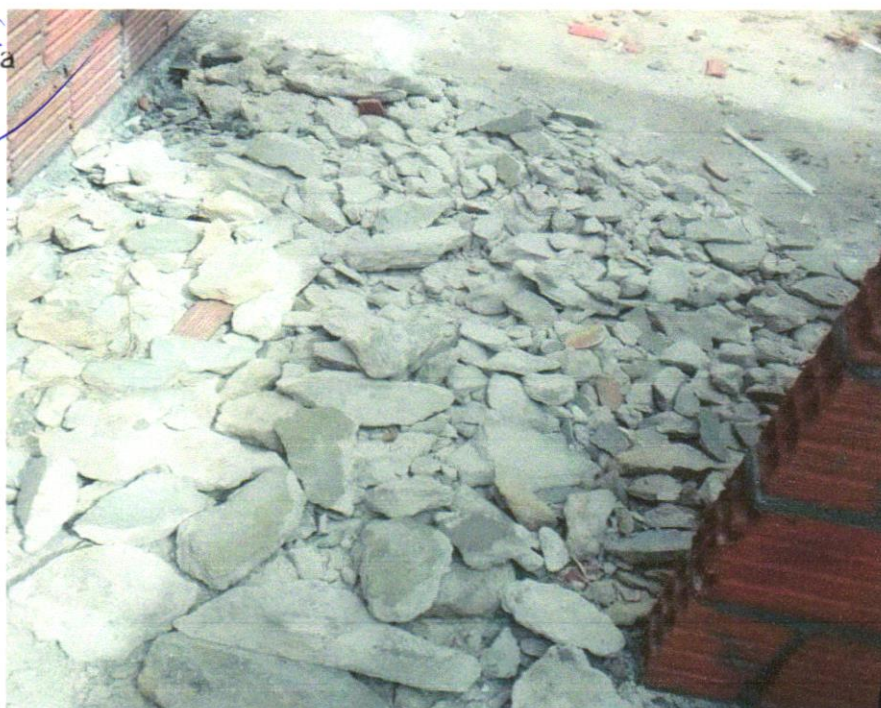
FOTO 06 - Demolição manual de piso cimentado sobre lastro de concreto - Rev 01
